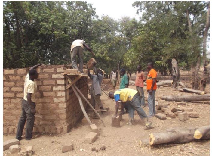
Photo : Construction d'une cantine scolaire.
